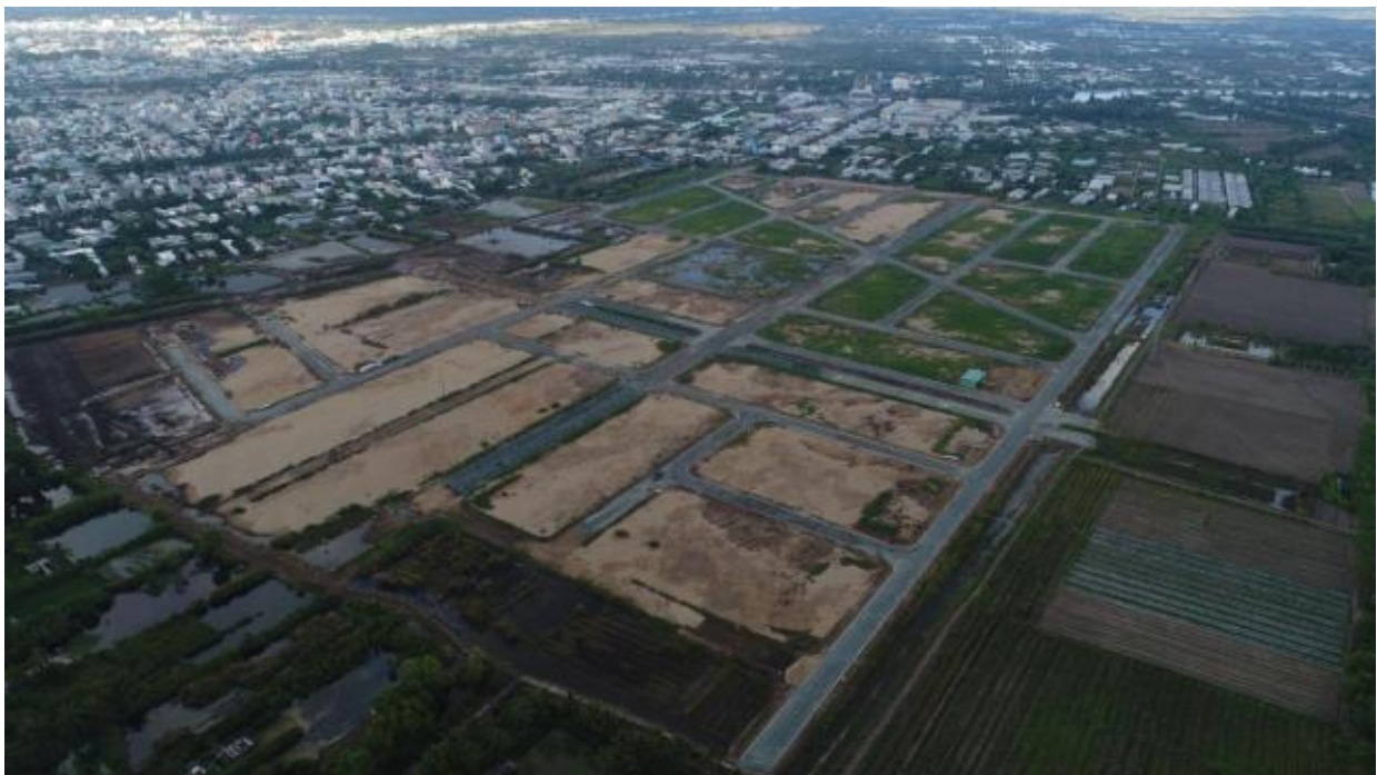
Thực địa dự án Khu dân cư phía đông QL1A xã Lý Văn Lâm – TP Cà Mau – tỉnh Cà Mau
