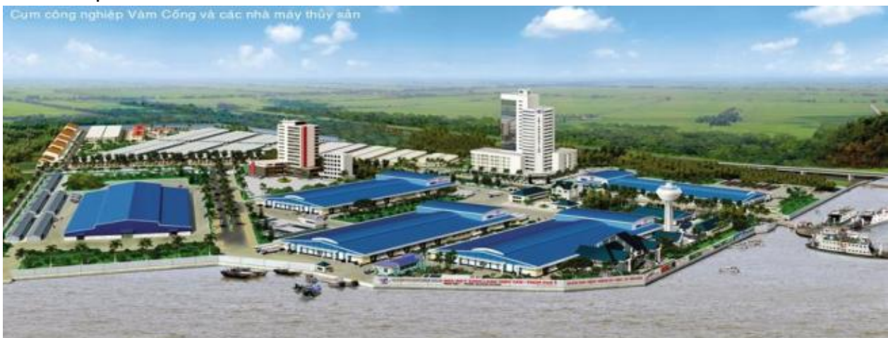
Cụm công nghiệp Vàm Cống và các nhà máy thủy sản
