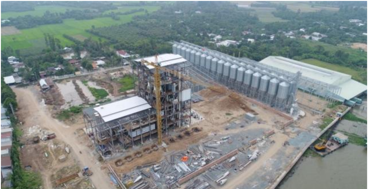
Thực địa tiến độ thi công dự án Nhà máy chế biến thức ăn thủy sản
